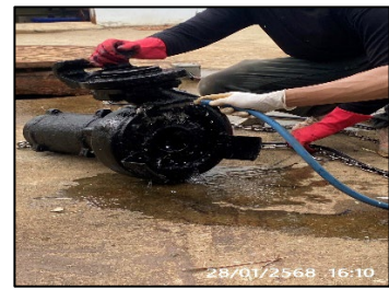
ภาพที่ ค-11 ซ่อมแซมระบบบำบัดน้ำเสียโดยทำตะแกรงป้องกันมีเดียหลุด ระหว่างเดือนมกราคม - มิถุนายน 2568
