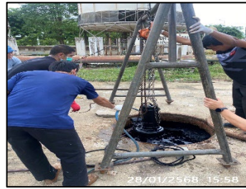
ภาพที่ ค-11 ซ่อมแซมระบบบำบัดน้ำเสียโดยทำตะแกรงป้องกันมีเดียหลุด ระหว่างเดือนมกราคม - มิถุนายน 2568
