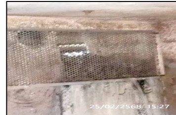
ภาพที่ ค-11 ซ่อมแซมระบบบำบัดน้ำเสียโดยทำตะแกรงป้องกันมีเดียหลุด ระหว่างเดือนมกราคม - มิถุนายน 2568
