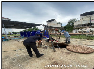
ภาพที่ ค-11 ซ่อมแซมระบบบำบัดน้ำเสียโดยทำตะแกรงป้องกันมีเดียหลุด ระหว่างเดือนมกราคม - มิถุนายน 2568
