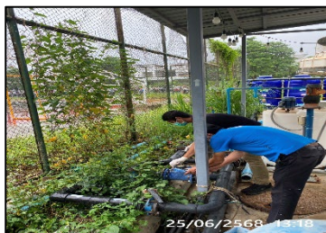
ภาพที่ ค-12 ตรวจสอบการทำงานของเครื่องเติมอากาศของระบบบำบัดน้ำเสีย และบำรุงรักษาระบบบำบัดน้ำเสีย ระหว่างเดือนมกราคม - มิถุนายน 2568
