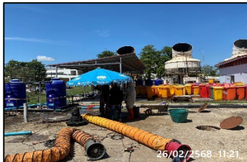
ภาพที่ ค-11 ซ่อมแซมระบบบำบัดน้ำเสียโดยทำตะแกรงป้องกันมีเดียหลุด ระหว่างเดือนมกราคม - มิถุนายน 2568
