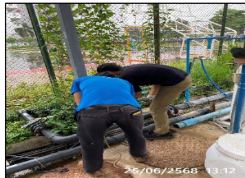
ภาพที่ ค-12 ตรวจสอบการทำงานของเครื่องเติมอากาศของระบบบำบัดน้ำเสีย และบำรุงรักษาระบบบำบัดน้ำเสีย ระหว่างเดือนมกราคม - มิถุนายน 2568
