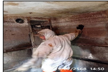
ภาพที่ ค-11 ซ่อมแซมระบบบำบัดน้ำเสียโดยทำตะแกรงป้องกันมีเดียหลุด ระหว่างเดือนมกราคม - มิถุนายน 2568
